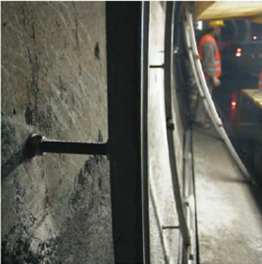
Nuestro anclaje SITA, en su versión en acero Inox AISI 316L, ha estado ampliamente utilizado en la cantera del "Monte Blanco" para fijar la estructura metálica de apoyo del panel de revestimiento de las paredes de la galería. Homologada con resistencia al fuego 120' segun curva de la temperatura ISO 834 en IBMB Braunschweig.
