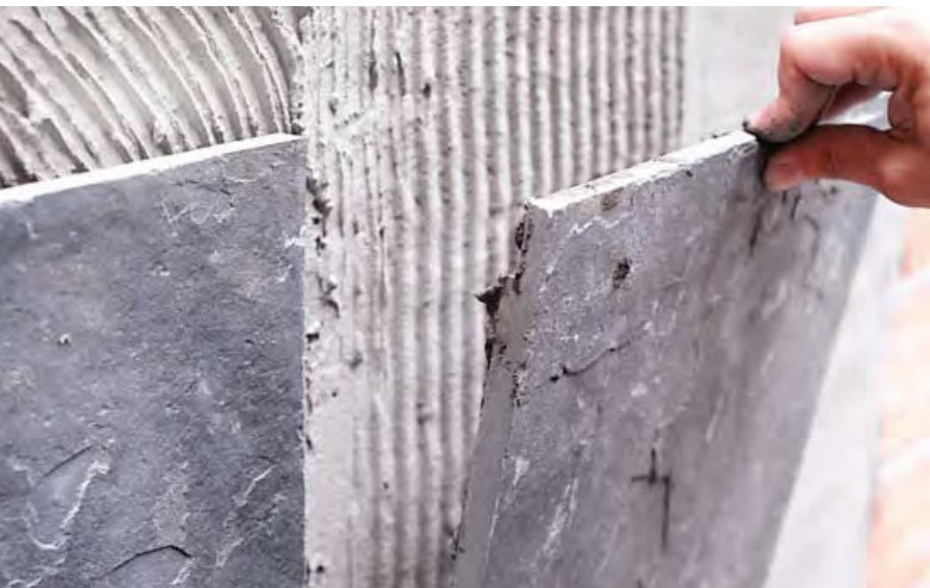
Adhesivo cementoso de altas prestaciones de uso interior y exterior, para la colocación en capa fina de piezas cerámicas de baja absorción.
