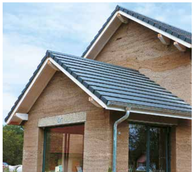
CASA DE HORMIGÓN DE CÁÑAMO Arbusigny (Alta Saboya)
