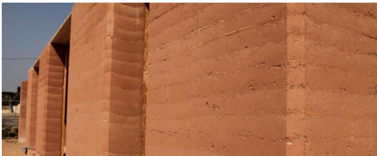
Muro tapial estabilizado con cal NHL 5
