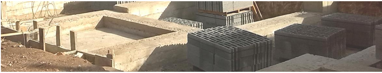
Cimentaciones con hormigón de Cal NHL 5 en una promoción de 14 viviendas (FORMENTERA)
