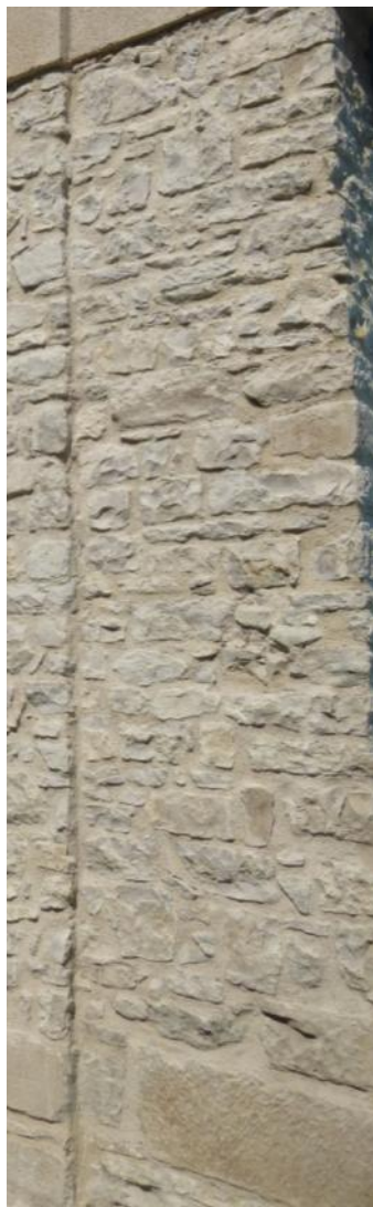
Muro piedra Cal NHL 5
