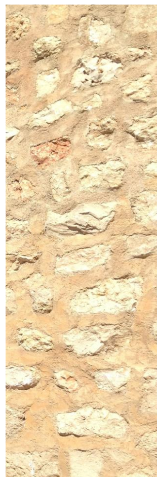
Rejuntado Cal NHL 3.5
