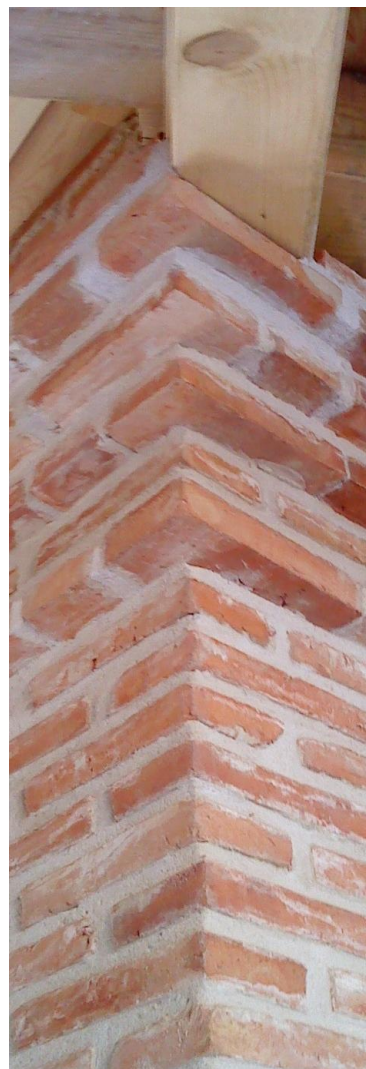
Pilar estructural Cal NHL 5
