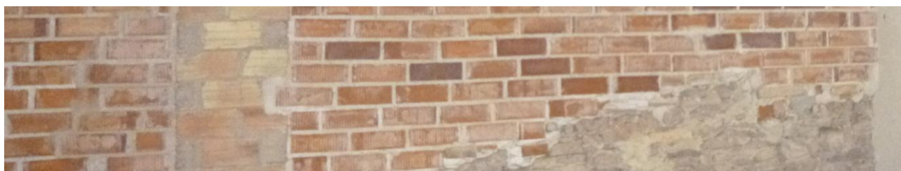
Muro Cal NHL 5 listo para recubrir
