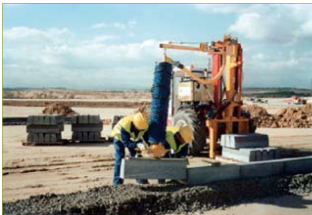
>> Colocación mecanizada de bordillos
