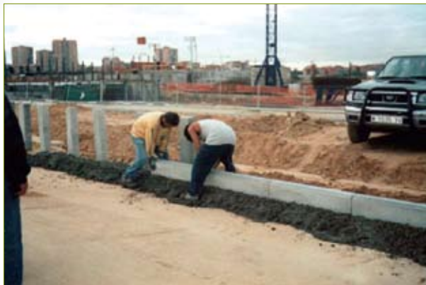
>> Colocación manual de bordillos
