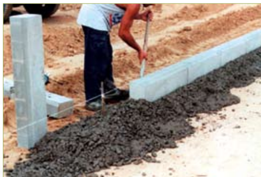
>> Ejecución del trasclusado con mortero de cemento
