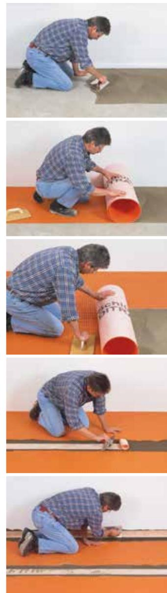
geotextil inmediatamente en la capa de adhesivo aplicada y se presionará sobre la misma con un fratás o rodillo de presión siguiendo la misma dirección. Se debe respetar el tiempo abierto del adhesivo. Durante la colocación de la lámina Schlüter-DITRA 25, ésta deberá alinearse correctamente.
