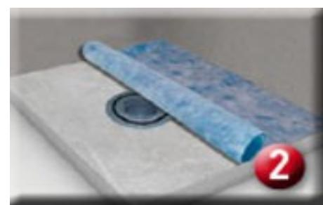
**2** Conecte la cazoleta al bajante y nivele el suelo fijando con hormigón ó cemento rápido hasta dejar la cazoleta al nivel del suelo . Prepare el suelo del plato de ducha con una capa de cemento cola donde solapar la tela e incluso también en la pared si es necesario . Ya puede solapar la tela de geotextil azul sobre el cemento cola con la ayuda de una llana .
